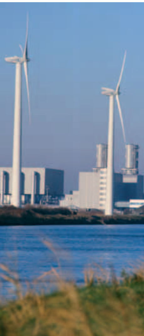
Windturbines vóór de gas/stoomcentrale van Herdersbrug in België
