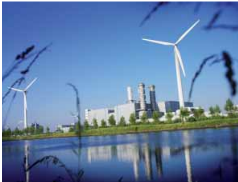
TGS-centrale (turbine gas-stoom) van Herdersburg (België)
